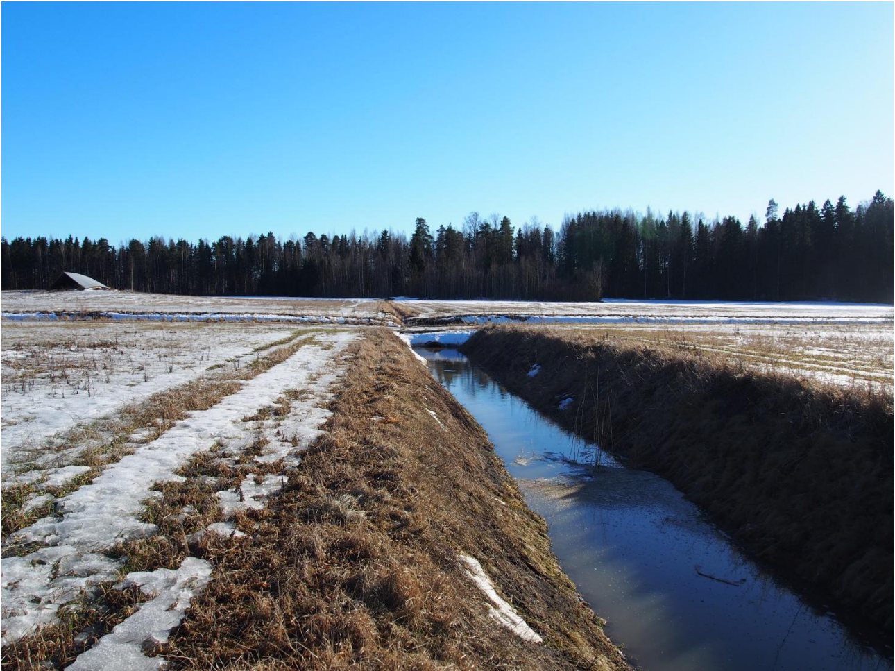
Kuva 11. Hulevesialtaiden purkuojan toinen pää. Tutkimuspisteen D30 läheisyydestä. Valokuva kohti Räikilänojaa.
